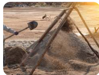
Gambar 5.26 Metode pengayakan yang dilakukan oleh pekerja bangunan.
