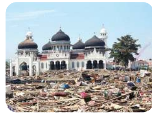
Gambar 6.17 Akibat gempa bumi di Aceh 26 Desember 2004.
