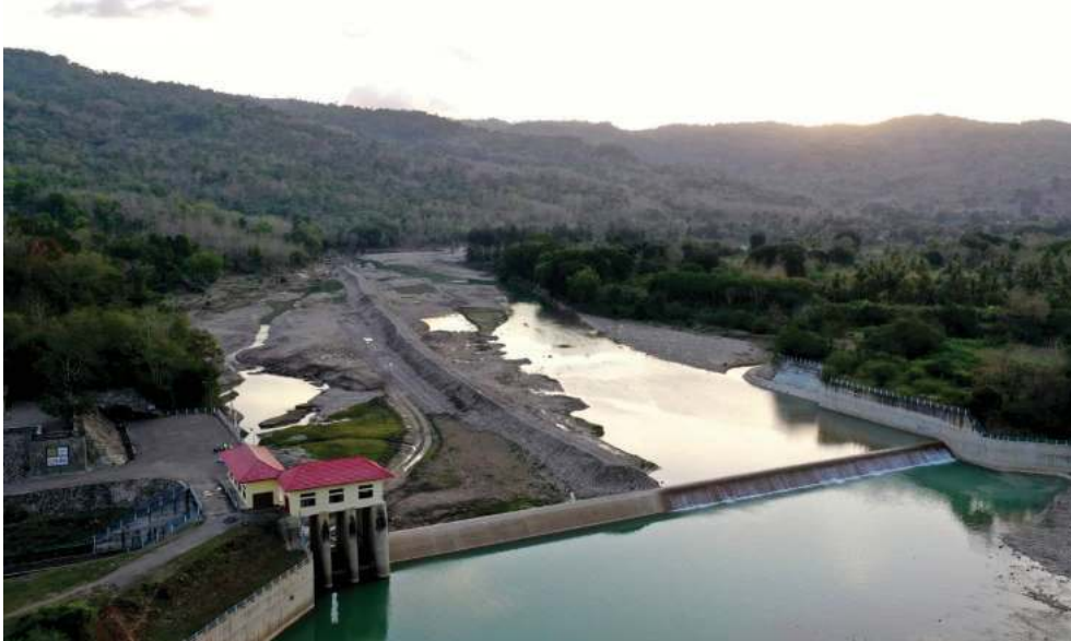
Gambar 4.35. Rehabilitasi Bendungan Benenain NTT Sumber: Kementerian PUPR (2021)
