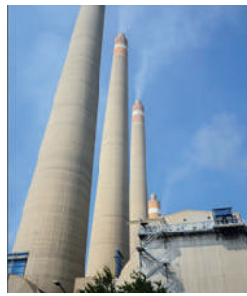
Cerobong asap pembangkit listrik
