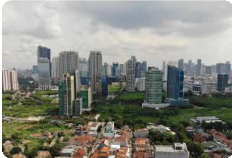
Gambar 2.6 Pembangunan yang tidak merata Sumber gambar : Afif Kusuma,2019
